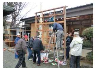
図 5-4. 提灯枠の設置
