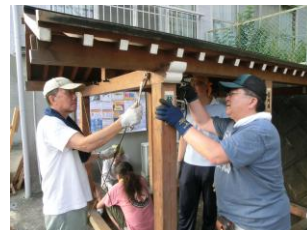
図 10-6. プレース(筋交い)を設置
